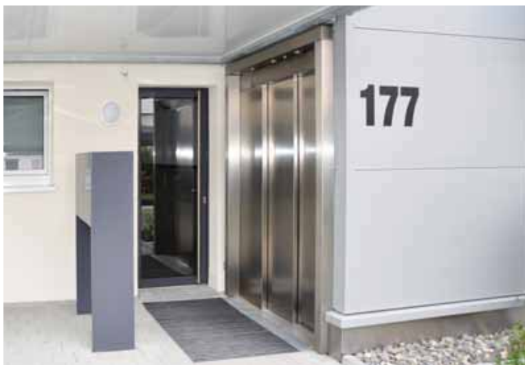
26 Barrierefreie Eingangssituation mit Klingel-/Briefkastenanlage und Aufzug (Mehrfamilienhaus)
