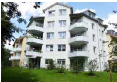
Garching, Am Mühlbach, Energetische Gebäudesanierung
