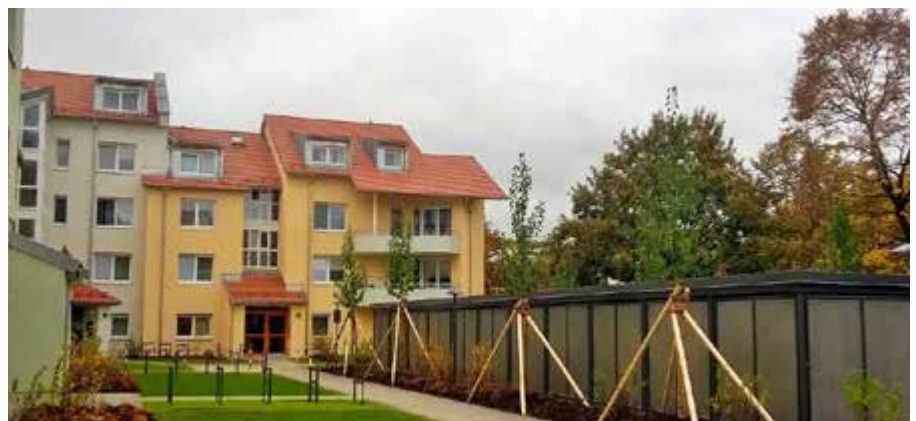
Energetisch sanierte Wohnanlage in Garching
